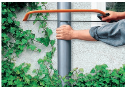
Udsavning af et ca. 30 cm langt stykke af nedløbsrøret
