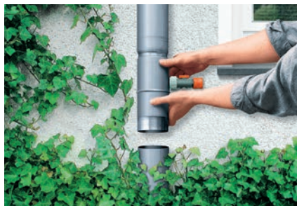
Nem montage og justering af RHEINZINK-Regnvandssamler
